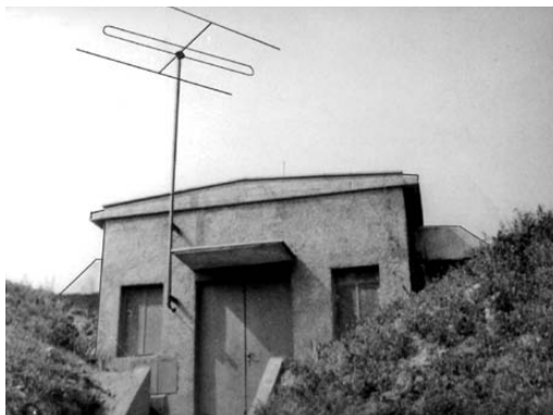
Vodojem s anténou pro přenos stavu hladiny.
