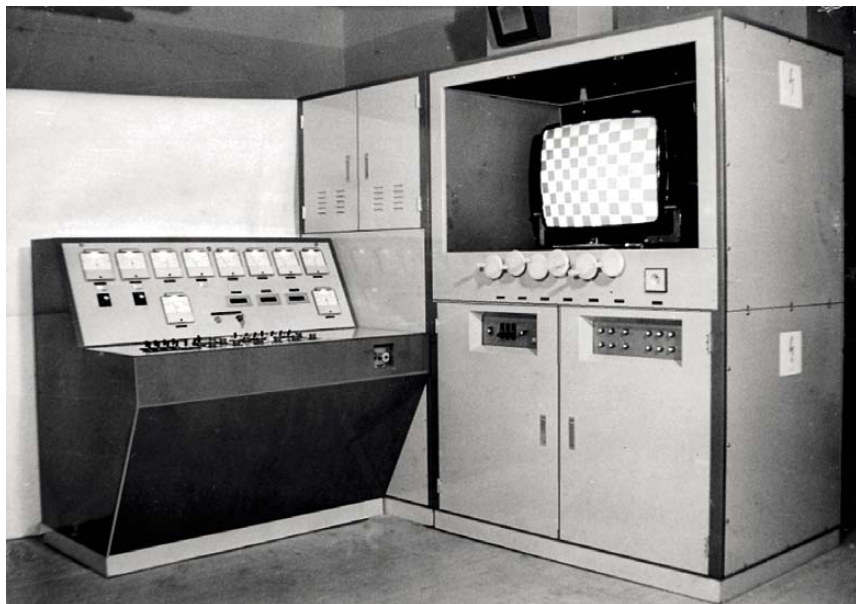
Kontrolní box ZOB 2
