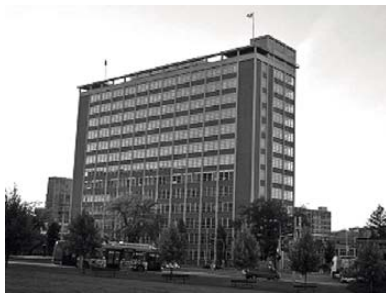
Zlínský Batův mrakodrap č. 21 s vysílací anténou na střeše
