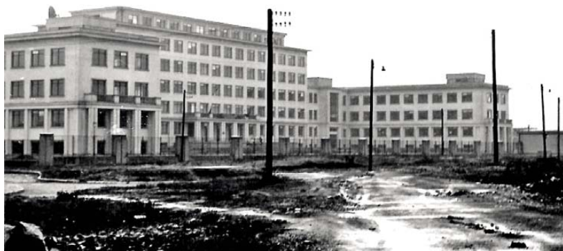
VÚST Novodvorská ve výstavbě
